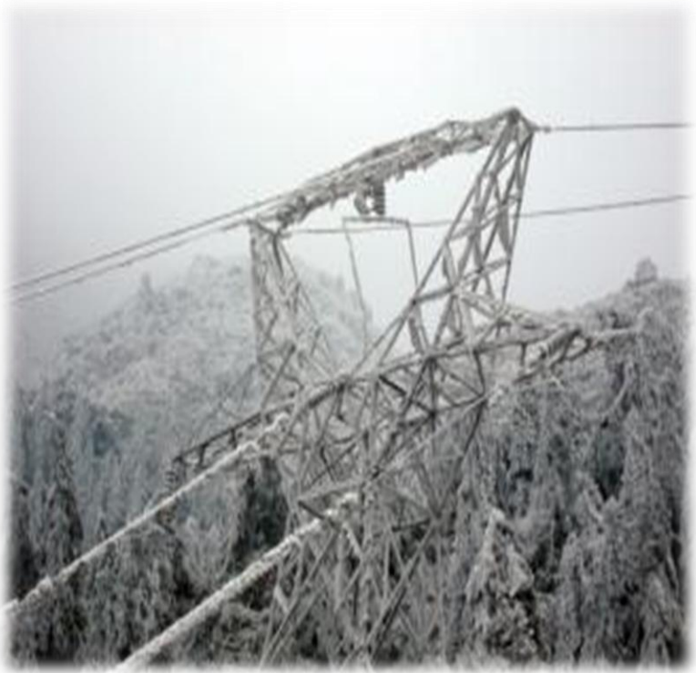
输电线路及铁塔
